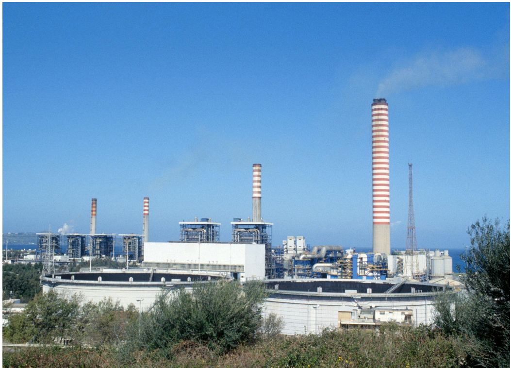
Vista della Centrale
